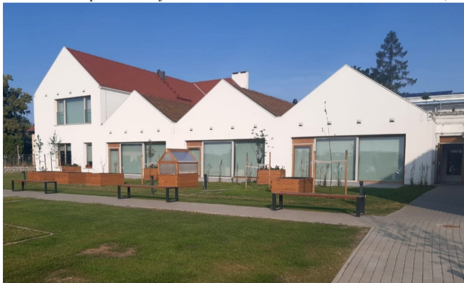
■ Rogów Sobócki, przebudowa szkoły
